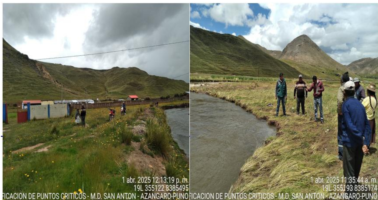
FIGURA N°02: TRAMO VULNERABLE Y SE EVIDENCIA DE LA EROSION DE LA RIBERA DEL MARGEN DERECHA, PONIENDO EN RIESGO IEP, IEI, AREAS AGRICOLAS DEL SECTOR SAN JUAN DEL DISTRITO DE ASILLO, PROVINCIA DE AZANGARO - PUNO.
