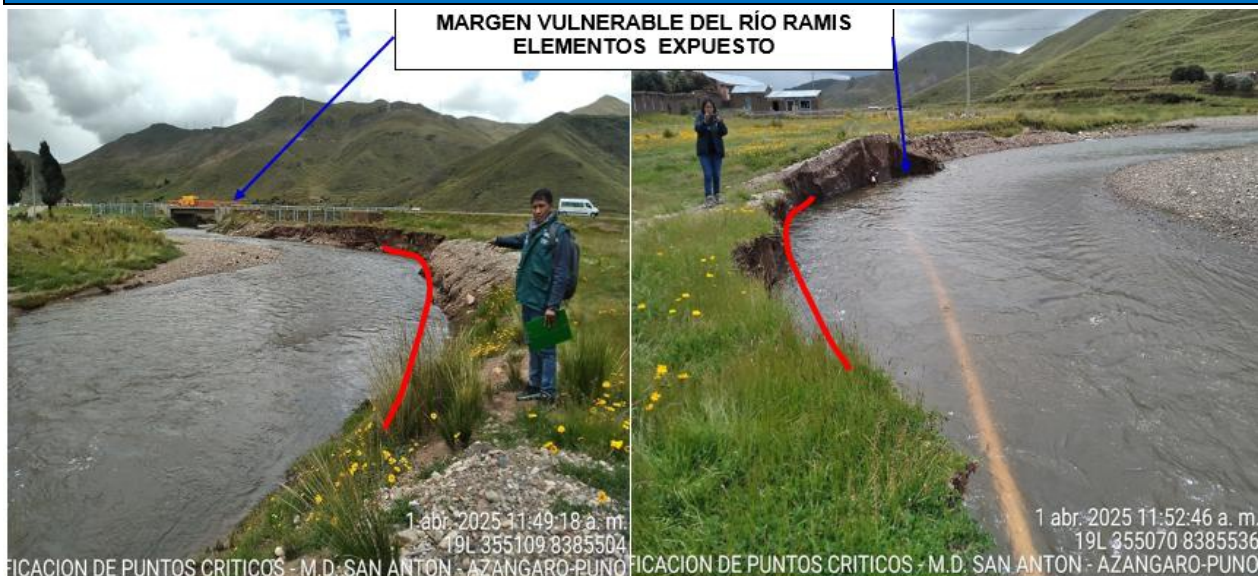
FIGURA N°01: TRAMO CRÍTICO EN EL RÍO SAN JUAN, DONDE SE EVIDENCIA LA EROSION DE LA RIBERA PONIENDO EN RIESGO PUENTE SAN JUAN, SISTEMA DE AGUA Y DESAGUE, DEL DISTRITO DE ASILLO, PROVINCIA DE AZANGARO - PUNO.
